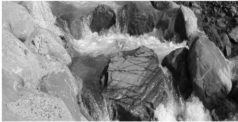
Figura 8 - Passaggio artificiale “close to nature.” per Salmonidi, sottotipologia rampa parziale, con l’utilizzo di massi e ciottoli reperiti in alveo, intasati di calcestruzzo; torrente Lima (PT). (Foto: E. Pini Prato)
