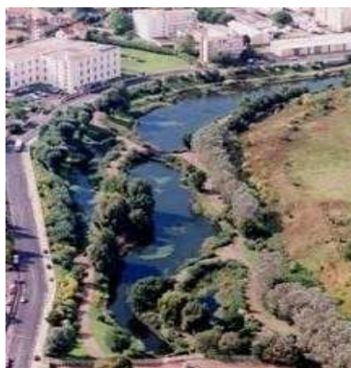
Figura 27 – A sinistra: impianto per il trattamento delle acque di prima pioggia in Toscana. A destra: impianto a flusso sommerso per il trattamento di scolmatori di reti miste (Germania)
