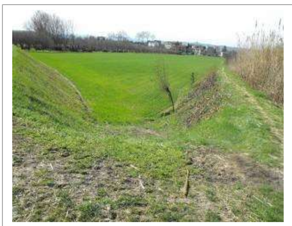
Il punto di giunzione fra l'argine sinistro del Ronco e destro del Rio Grotta
