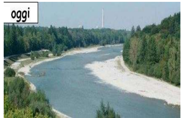
Figura 14 - Fiume Isar a Monaco di Baviera: viene ridato spazio al fiume e favorita la formazione di un tracciato più diversificato e fruibile arretrando le difese. Si noti la neo-formazione di barre interne al meandro.
