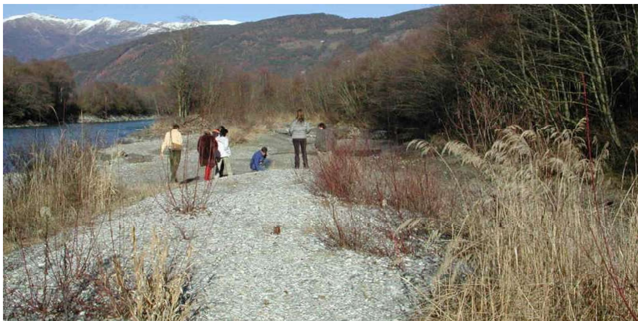
Figura 12 – Ampliamento dell'alveo mediante ricalibratura del canale – Fiume Drava (Austria)
