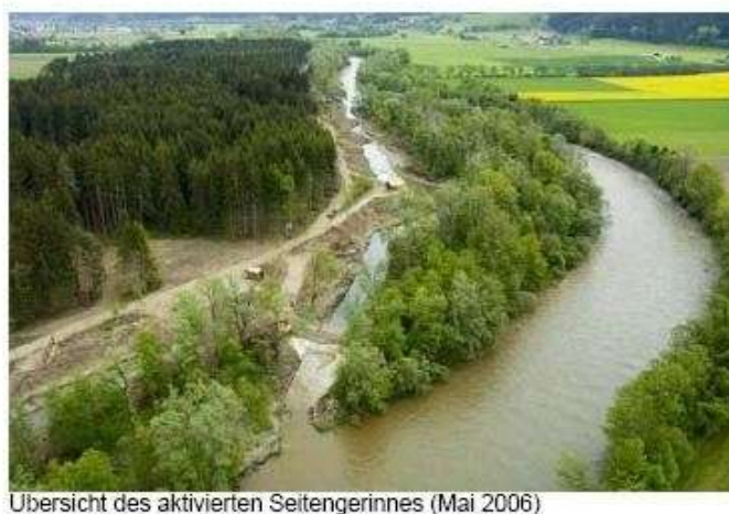
Figura 17 – Creazione di un canale secondario nel fiume Obere Mur in Austria
