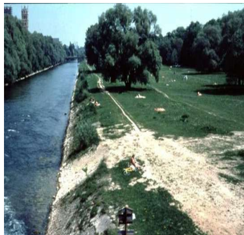
Figura 14 - Fiume Isar a Monaco di Baviera: viene ridato spazio al fiume e favorita la formazione di un tracciato più diversificato e fruibile arretrando le difese. Si noti la neo-formazione di barre interne al meandro.
